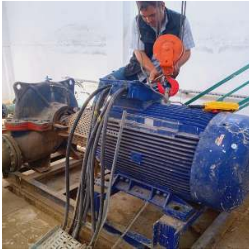
Çiçekli Göleti Kontrol Odası Pompa Tamirâtı
