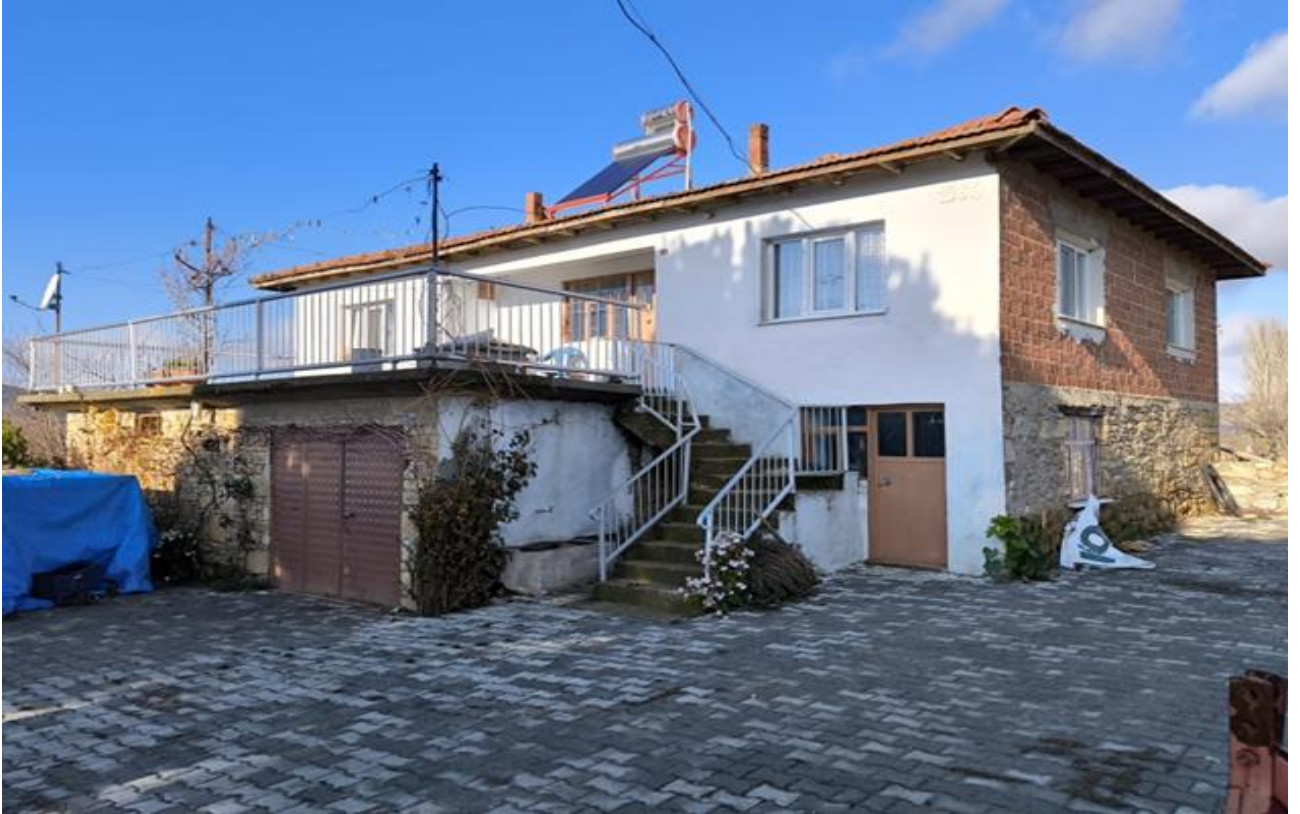
Bina Tespit Değerlendirme Raporu Düzenlenen Bina Örneği
