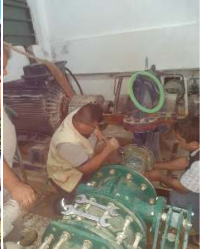
Çiçekli Göleti Kontrol Odası Pompa Tamirâtı
